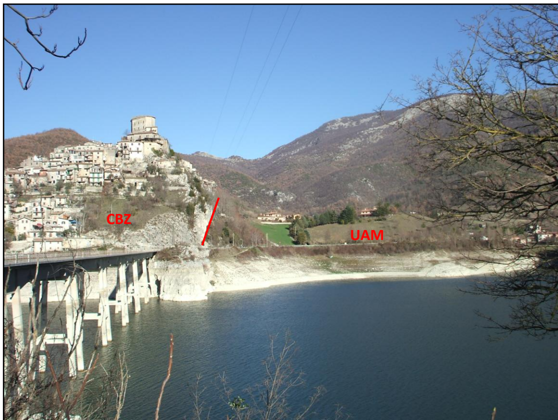
CASTEL DI TORA CAPOLUOGO: NUCLEO STORICO FONDATO SULLA FORMAZIONE CDZ IN CONTATTO TETTONICO CON LA FORMAZIONE UAM. VISTA LATERALE
