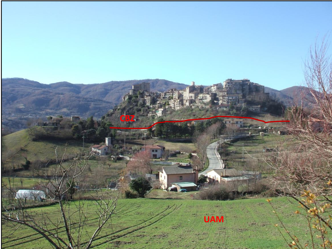
CASTEL DI TORA CAPOLUOGO: NUCLEO STORICO FONDATO SULLA FORMAZIONE CDZ IN CONTATTO TETTONICO CON LA FORMAZIONE UAM. VISTA FRONTALE
